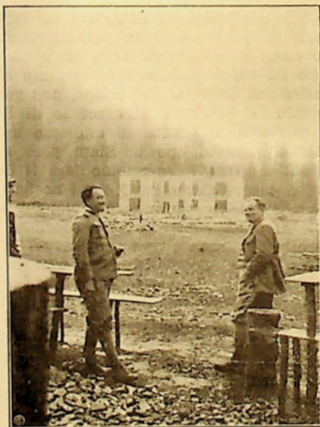
I LAVORI AL RIFUGIO VERSO LA FINE DI OTTOBRE
