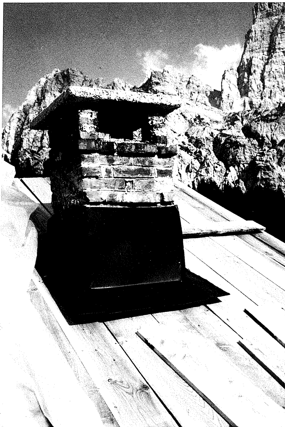
Rifugio «Città di Fiume». Un particolare del rifacimento del tetto (1988).
