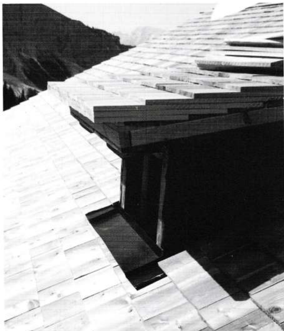
Rif. «Città di Fiume». Alcuni particolari del rifacimento del tetto (1988)
